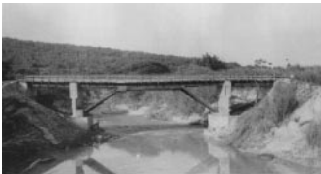
Figura 5. Ponte sobre o Rio Vespasiano.
